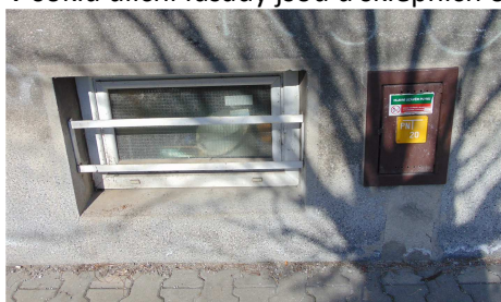
typ stávajících skříní HUP
