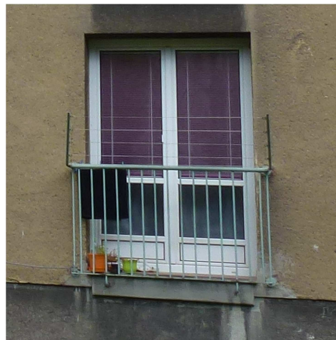
typ zábradlí francouzských oken
