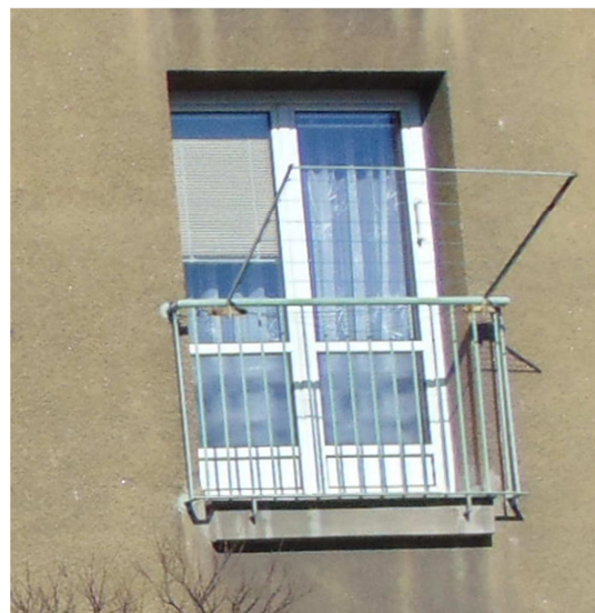
typ zábradlí francouzských oken
