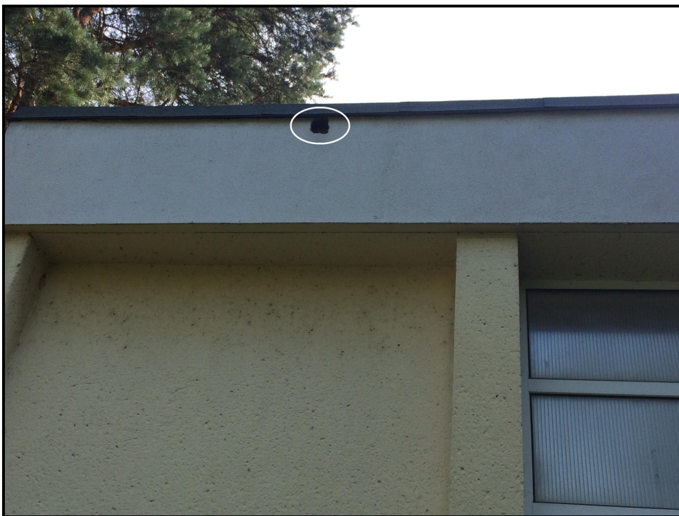
Obr. 5: Díra v zateplení s otisky rýdovacích per kavky obecné (elipsa) na JZ straně budovy E
