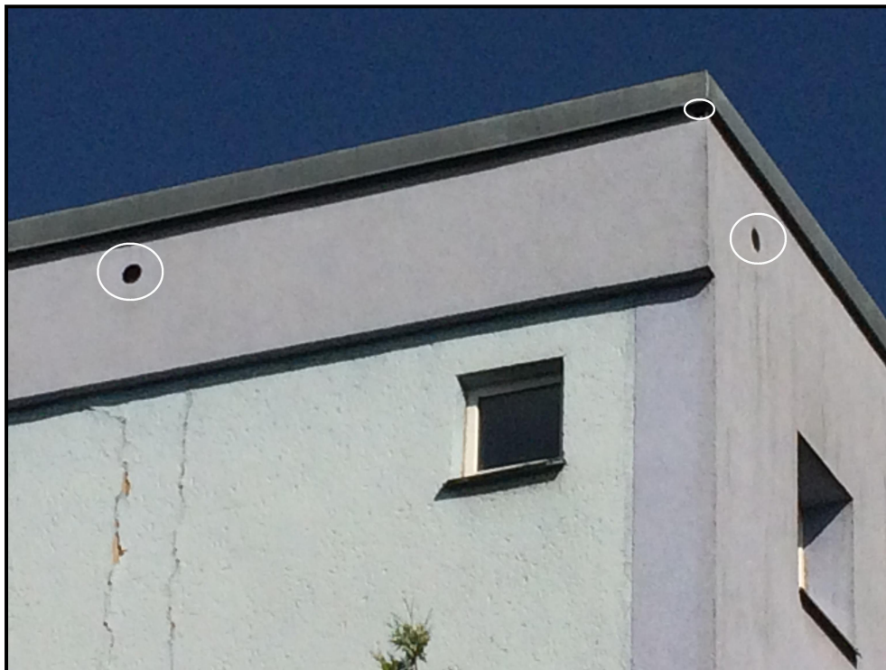
Obr. 1: Díra (malá elipsa) v zateplení a dva podstrešní ventilační otvory bez mřížek (velké elipsy) u SV rohu budovy A – stanoviště kavky obecné (velká elipsa vlevo) a potenciální stanoviště dalších předmětných živočichů
