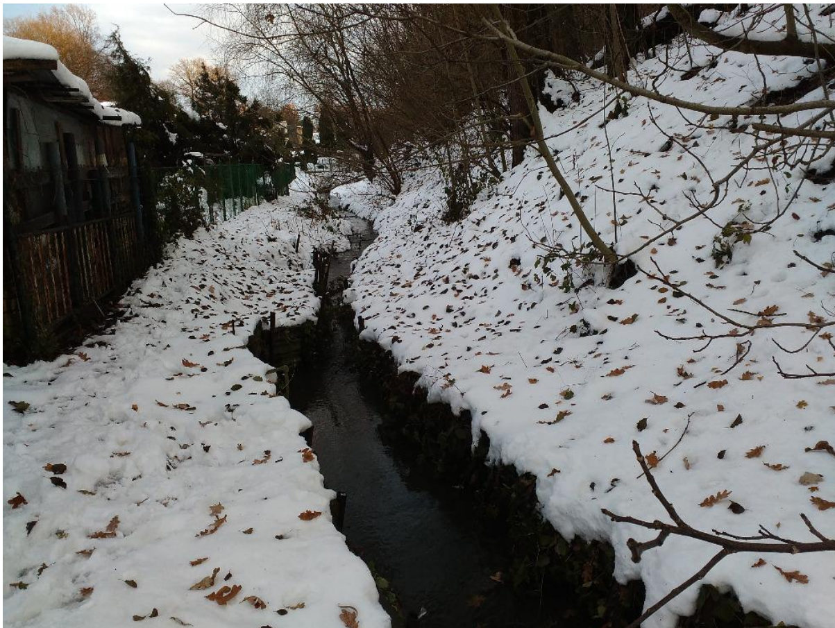
Obr. č. 3 Pohled na DVT Skřečonský potok řkm 1,942 - 1,967 – zúžení průř. profilu.
