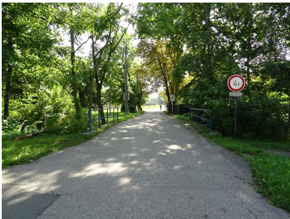
Pohled na most směrem od ul. Ostravská a železniční trati k ul. Drátovská (ve směru popisu prohlídky)
