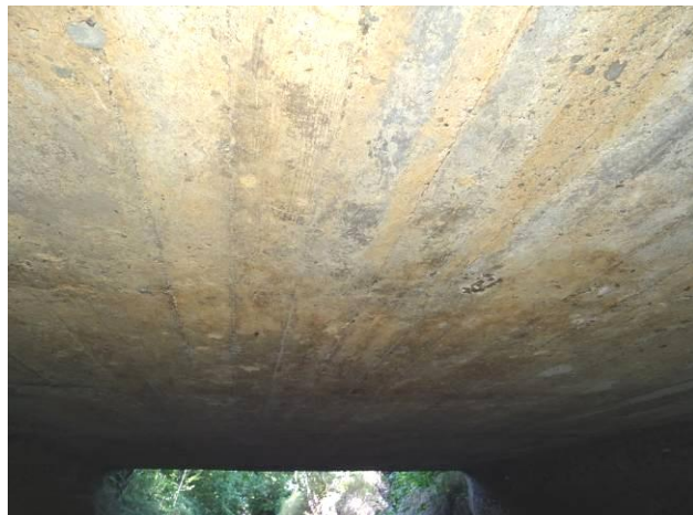
Podhled nosné konstrukce
