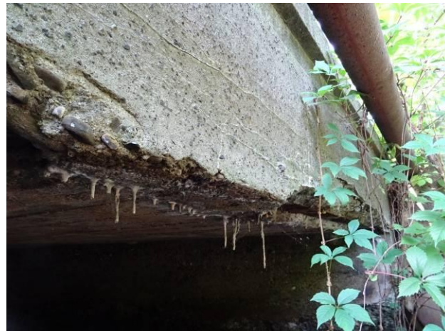
Levý bok nosné konstrukce (výtok) – detail
