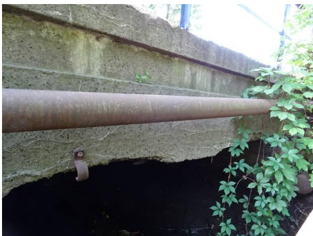
Levý bok nosné konstrukce (výtok)
