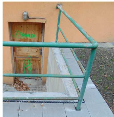
zrekonstruovaný sjezd k J štítu +opravené zídky bez betonových hlav +zábradlí
