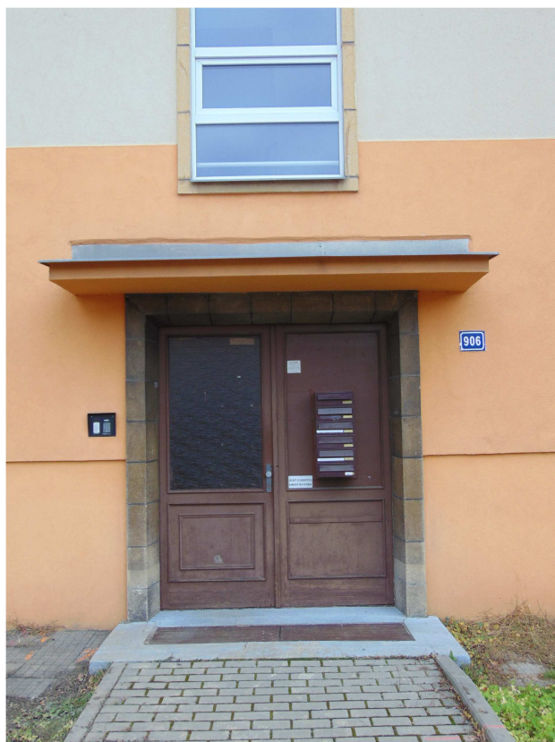
hlavní vstup s železobetonovou stříškou a novým přístupovým chodníkem
