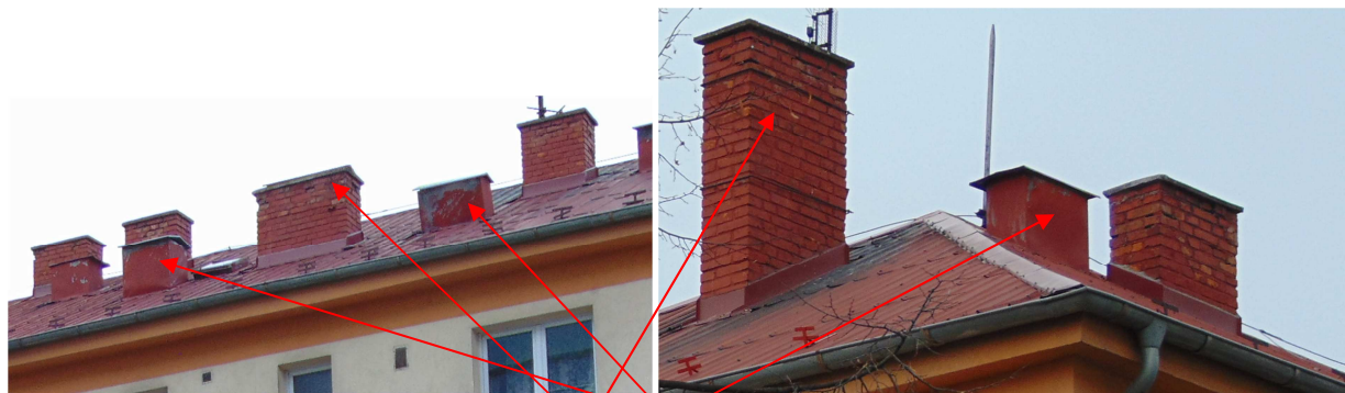
stav komínů s betonovými hlavami oplechované bloky ventilací WC
