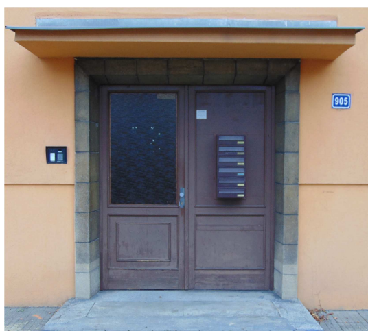
hlavní vstup s profilovaným teracovým portálem
