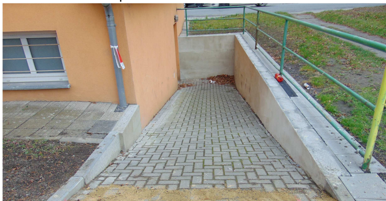
zrekonstruovaný sjezd k J štítu +opravené zídky bez betonových hlav +zábradlí
