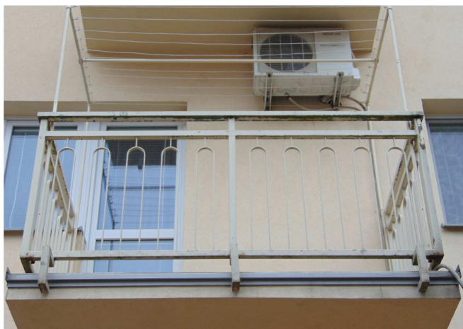
typ stávajících balkónů, včetně typu a způsobu kotvení balkónového zábradlí
