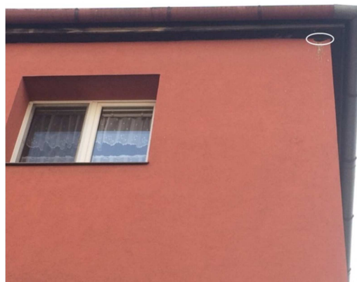
Obr. 2: Díra v zateplení se stopami trusu ptáků (elipsa) v SV rohu Seifertova č. p. 908
