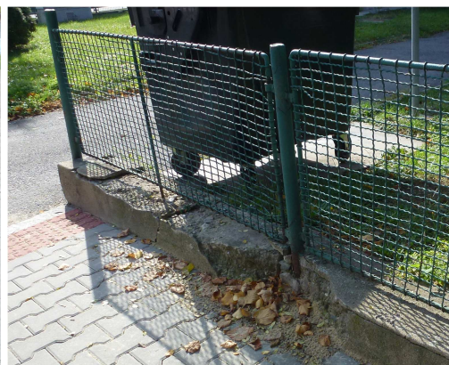
poškozená plotová podezdívka
