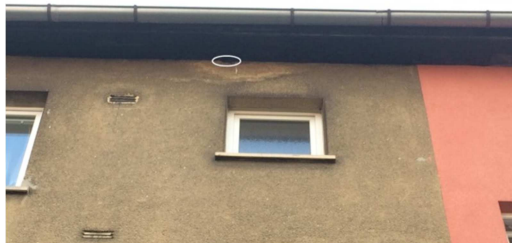
Obr. 1: Dutina mezi bedněním atikové římsy a fasádou se stopou trusu ptáků (elipsa) na SV straně č. p. 920 – pravděpodobné přístupové místo na hnízdiště ptáků
