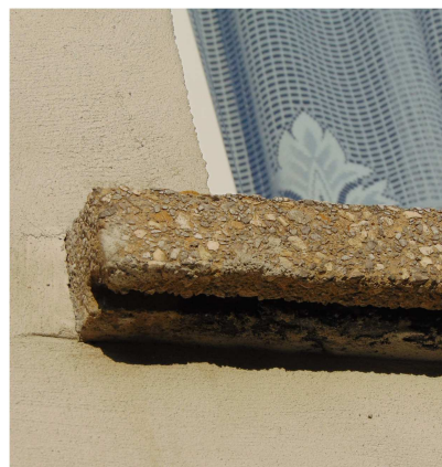
teracový parapet-V918-920
