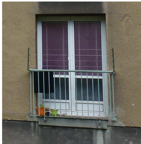
typ zábradlí francouzských oken
