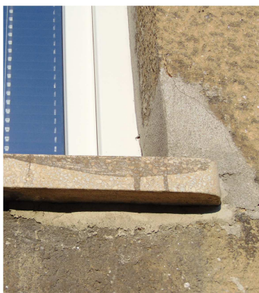
teracový parapet-V918-920
