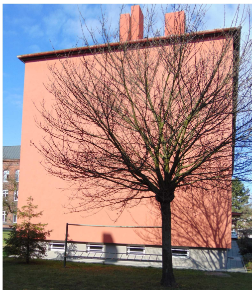
Vrchlického 912- zateplený JV štít Vrchlického 914- zateplený SZ štít
