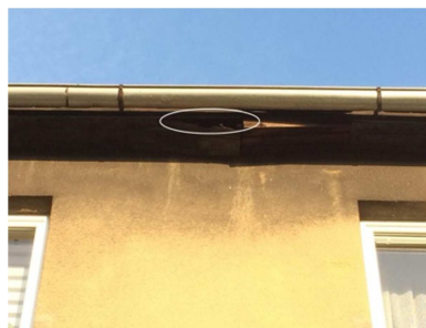
Obr. 2: Velká dutina v bednění atikové římsy (elipsa) na JZ straně č. p. 914 – potenciální přístupové místo na hnízdiště ptáků
