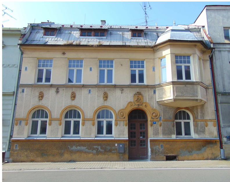
uliční fasáda objektu Slezská č.p.19
