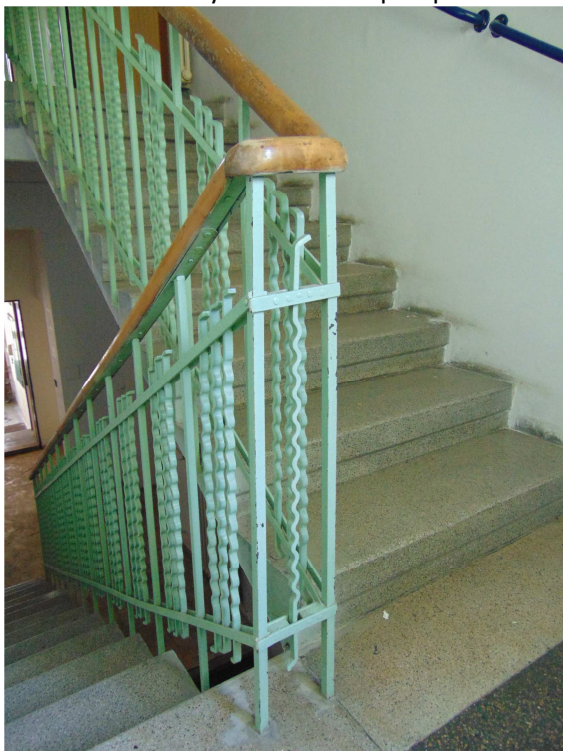
zábradlí vnitřního schodiště
