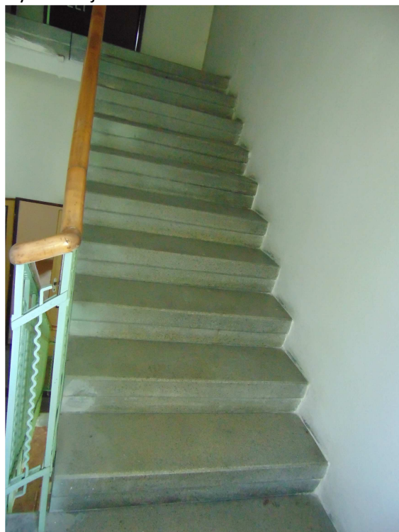
teracové schodišťové stupně
