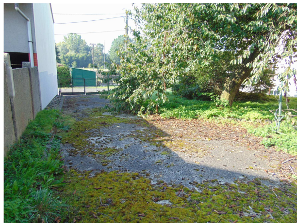
betonové zpevněné plochy na p.č.43
