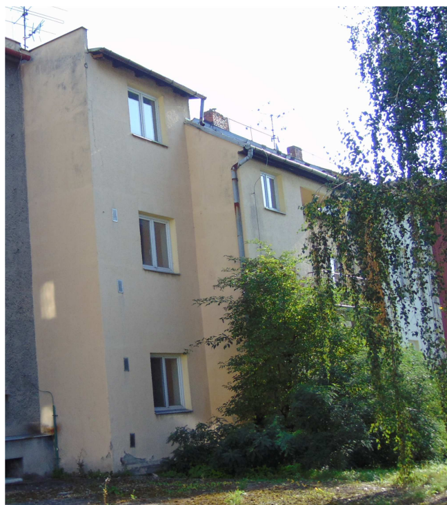
dvorní fasáda objektu Slezská č.p.19
