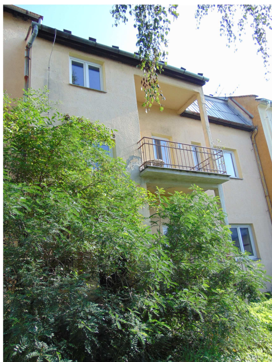
dvorní fasáda objektu Slezská č.p.19
