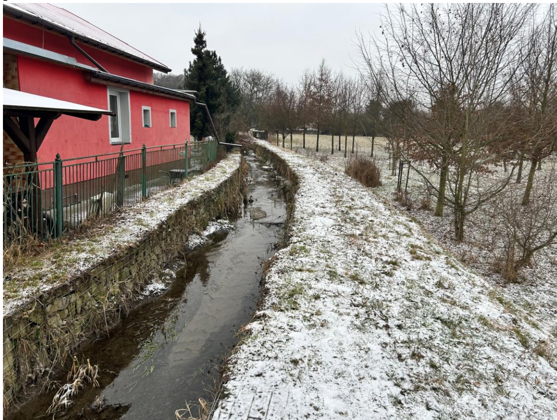
Obr. č. 1 Pohled na DVT Skřečonský potok řkm 1,119 - 1,199 – gabiónové opevnění L/B břehu s levobřežní zemní hrází.
