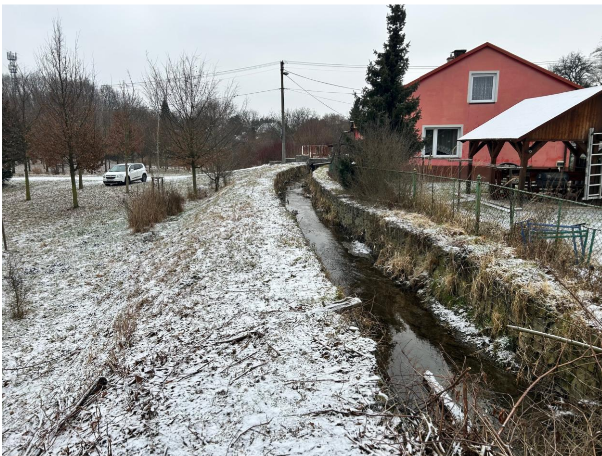
Obr. č. 4 Pohled na DVT Skřečošský potok řkm 1,119 - 1,199 – gabiónové opevnění L/B břehu s levobřežní zemní hrází.
