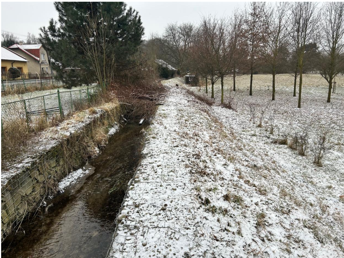
Obr. č. 3 Pohled na DVT Skřečošský potok řkm 1,119 - 1,199 – gabiónové opevnění L/B břehu s levobřežní zemní hrází.
